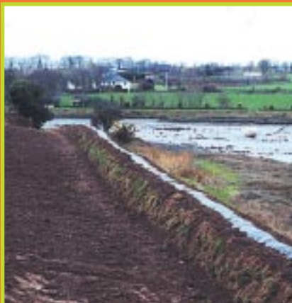
Le talus pour protéger l'eau du Bizien
