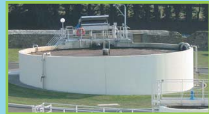
Station de traitement de Kernévec
