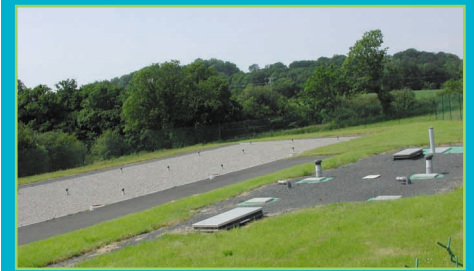
Vue de la fosse (partie gravillonnée) avec les cheminées d'évacuation des gaz.
