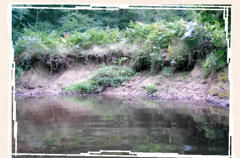
Le Jaudy, trop rapide ? Un bassin versant très pentu, des berges trop hautes et érodées : le Jaudy est en danger !
