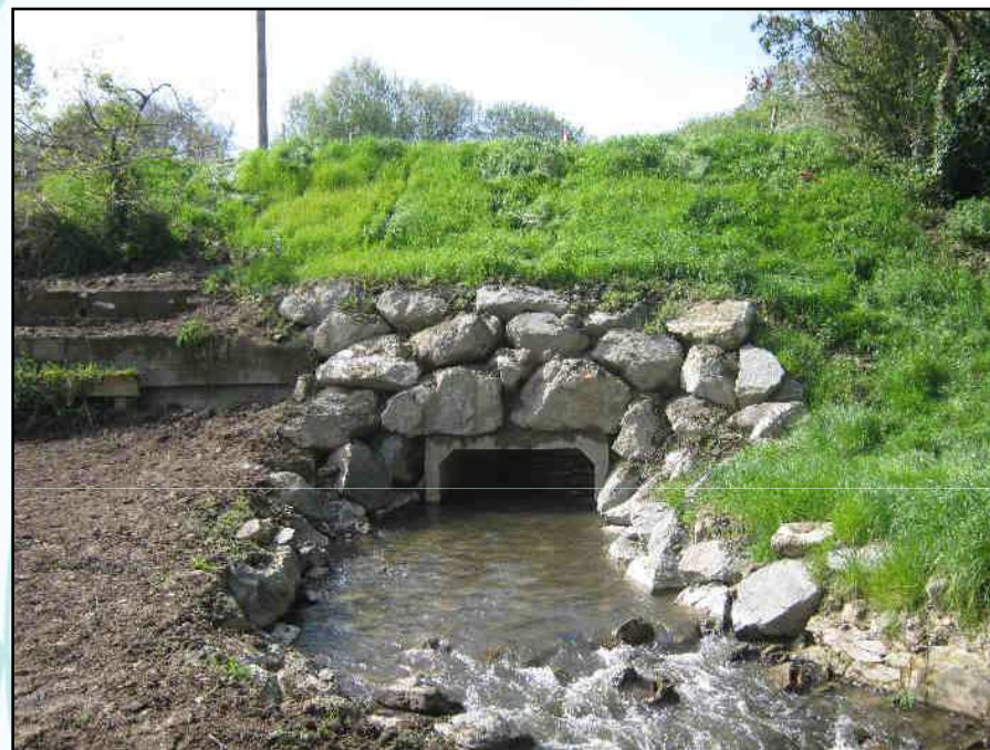
Ouvrage après travaux
