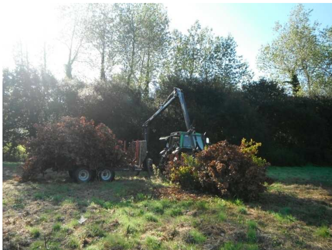
Travaux de restauration
