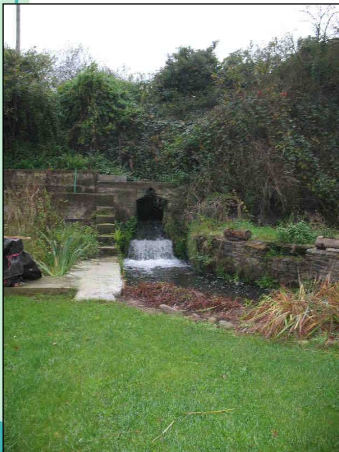
Ouvrage avant travaux (Hauteur de chute 3 m)
