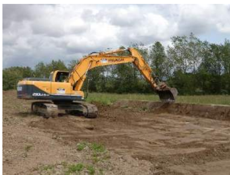
Photo 2 : Réalisation du talus par une pelle à chenille
