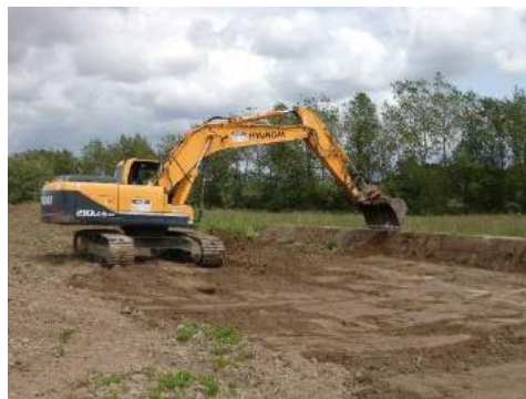
Photo 2 : Réalisation du talus par une pelle à chenille
